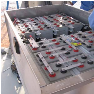
El banco de baterías está contenido en un alojamiento de acero inoxidable.
